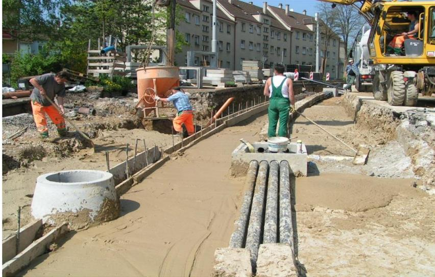
Beispiel einer Bodenplatte aus RSS Flüssigboden® (FB nach RAL GZ 507) unter einem Stadtbahngleis in Stuttgart – Zuffenhausen (analog Bahnbau z.B. Projekt Kastl)
